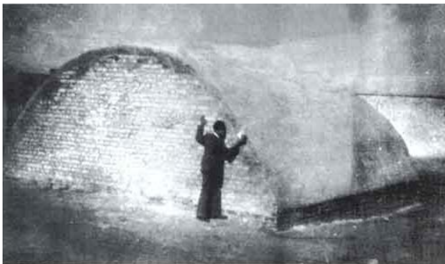
Il monumento sulla fossa comune per gli ebrei di Bagdad vittime del Farhud. Venne distrutto col vecchio cimitero ebraico di Bagdad durante la dittatura di Kassem, convinto da consiglieri sovietici a demolirlo per costruire due torri, ma non visse abbastanza per vederle costruite.
